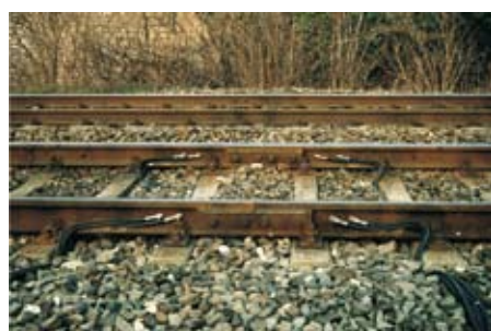
Połączenia metalowych elementów konstrukcyjnych do szyn powrotnych trakcji elektrycznej (uszynienia)
