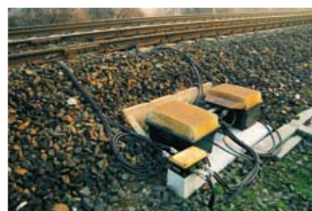
Drenaże elektryczne od metalowej infrastruktury podziemnej w kierunku szyn
